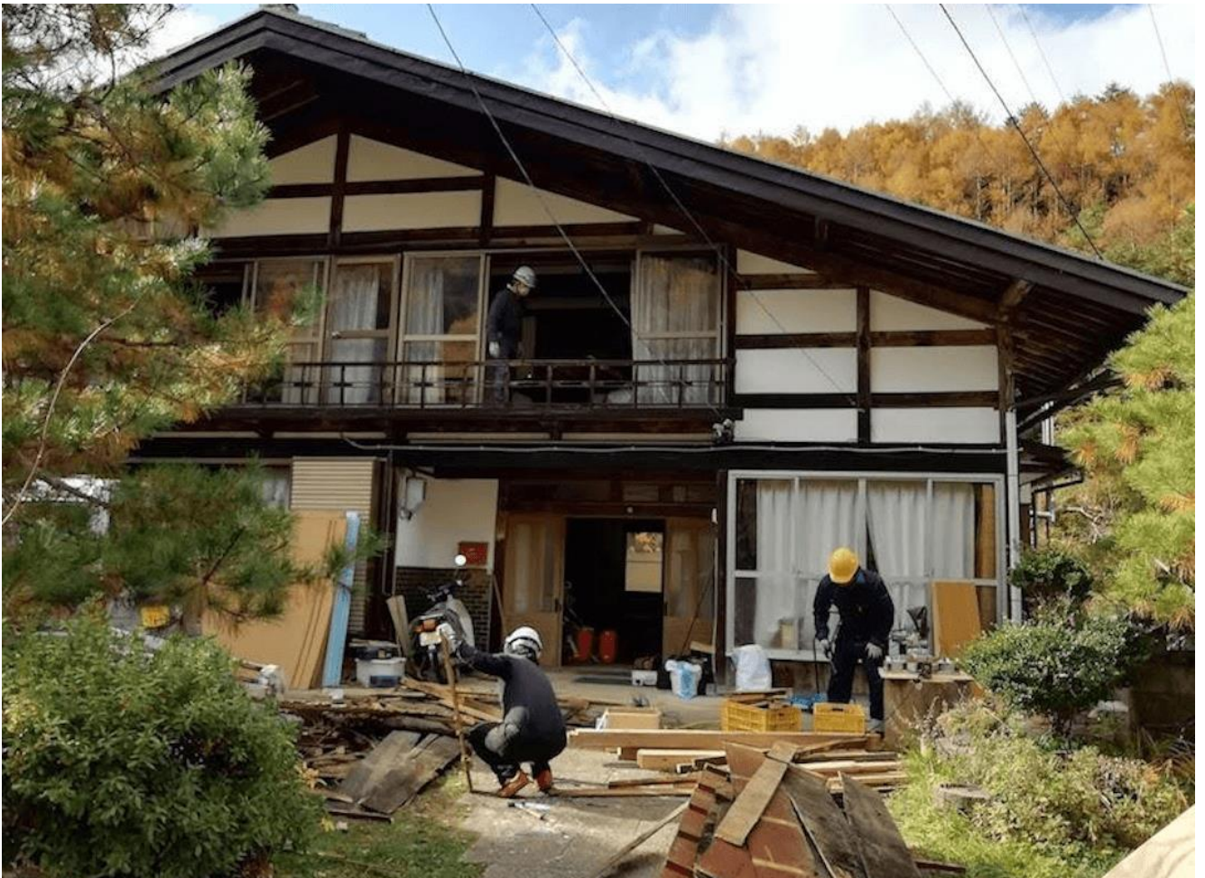
空き家 DIY 改修の様子
