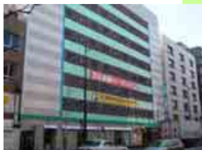
丸亀町第四駐車場(2004年4月オープン)
