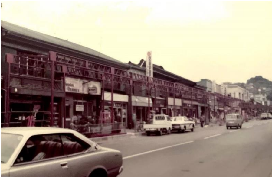
建設中のアーケード
