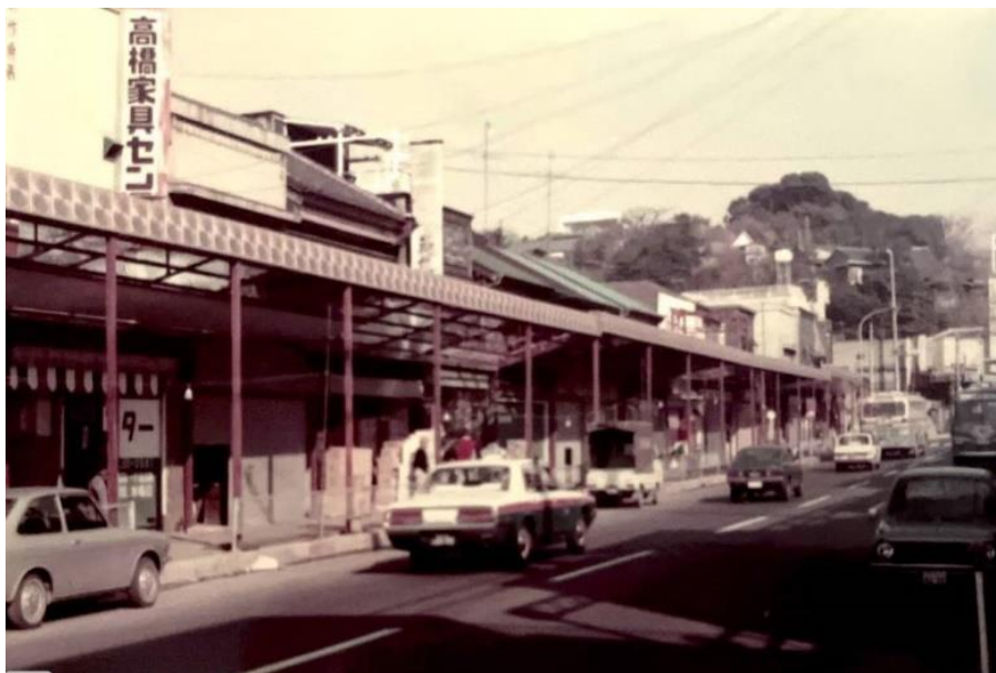
完成したアーケード
