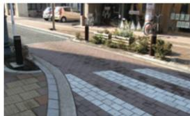
交差点から侵入する車道の幅員が狭められている。車を自ずと徐行させる工夫である。
