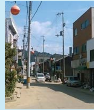
浸水によりカラー 舗装が損傷
