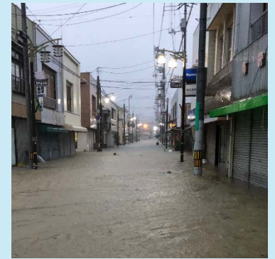
浸水により街路灯が故障
