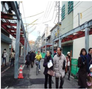
「アーケード改築中の上古町商店街」
