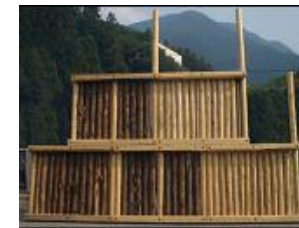
(間伐材を用いた型枠)
