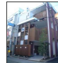
(古くからの街並みに配慮した外観の飲食店ビルの施工例)
