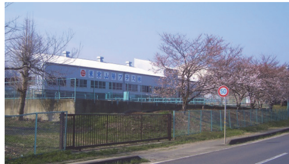
桜川工場外観
