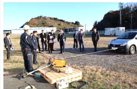
施工性試験状況
