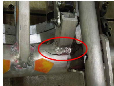
写真 2-2-13 母材の割れ（破断）の拡大
