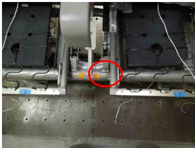
写真 2-2-12 母材の割れ（破断）
