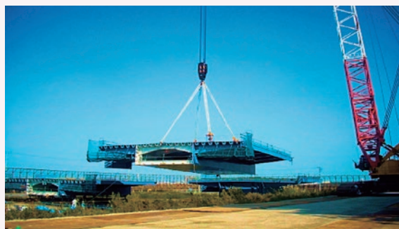
同社のヘビーラウンドスリングを使用した橋梁工事現場
