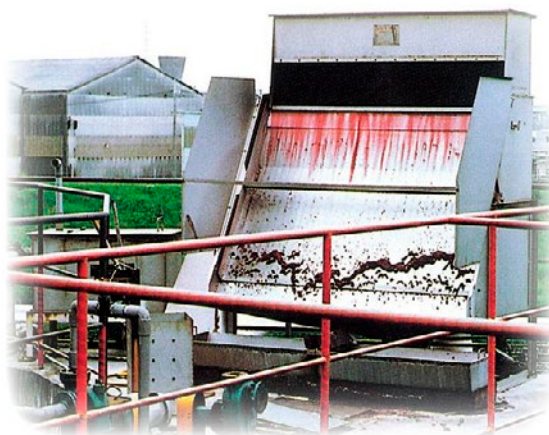
東洋スクリーン工業株式会社のウルトラ TN スクリーン (wedge wire screen を使用した傾斜式の固液分離装置)
