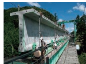
橋梁新設工事の様子
