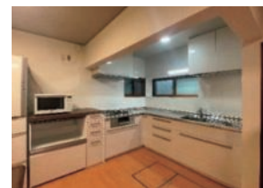
共同で手掛けたリフォーム工事
