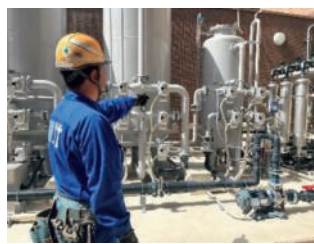
貯水槽設備の点検の様子
