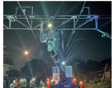
ロボットによるビームの塗装作業 （写真提供：JR 西日本）
