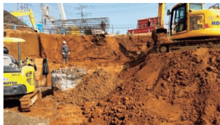
現場作業の様子
