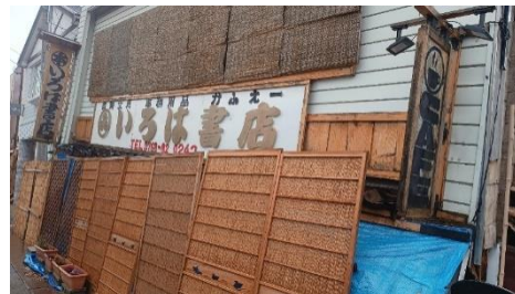
被災した旧店舗の外観
