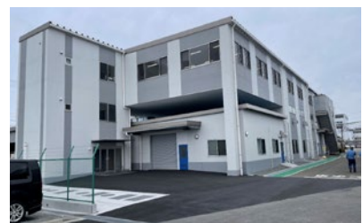
増築した水素分野の研究施設
