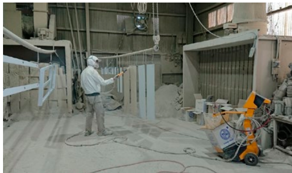
塗装作業の様子
