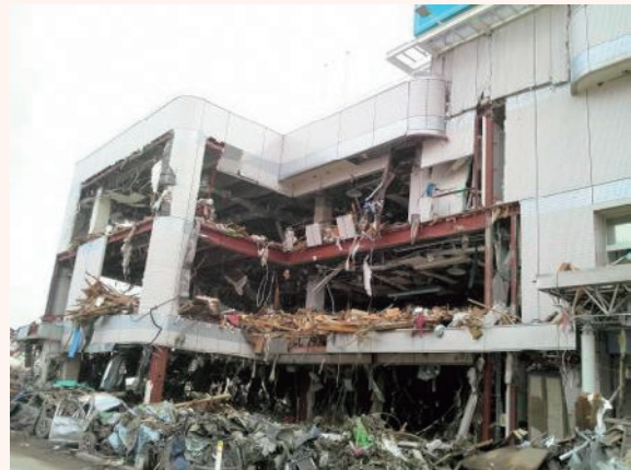
高田店の被災状況
