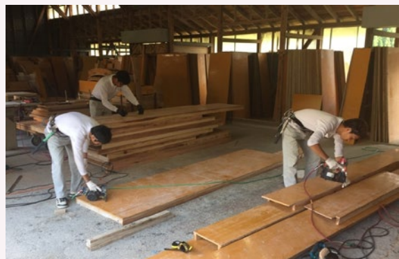
型枠加工の様子
