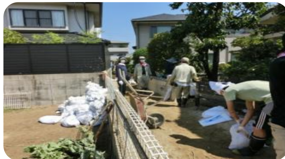
ボランティアによる土砂の撤去
