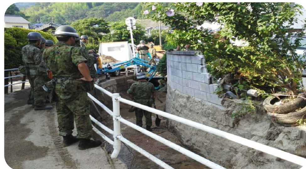
自衛隊による土砂の撤去
