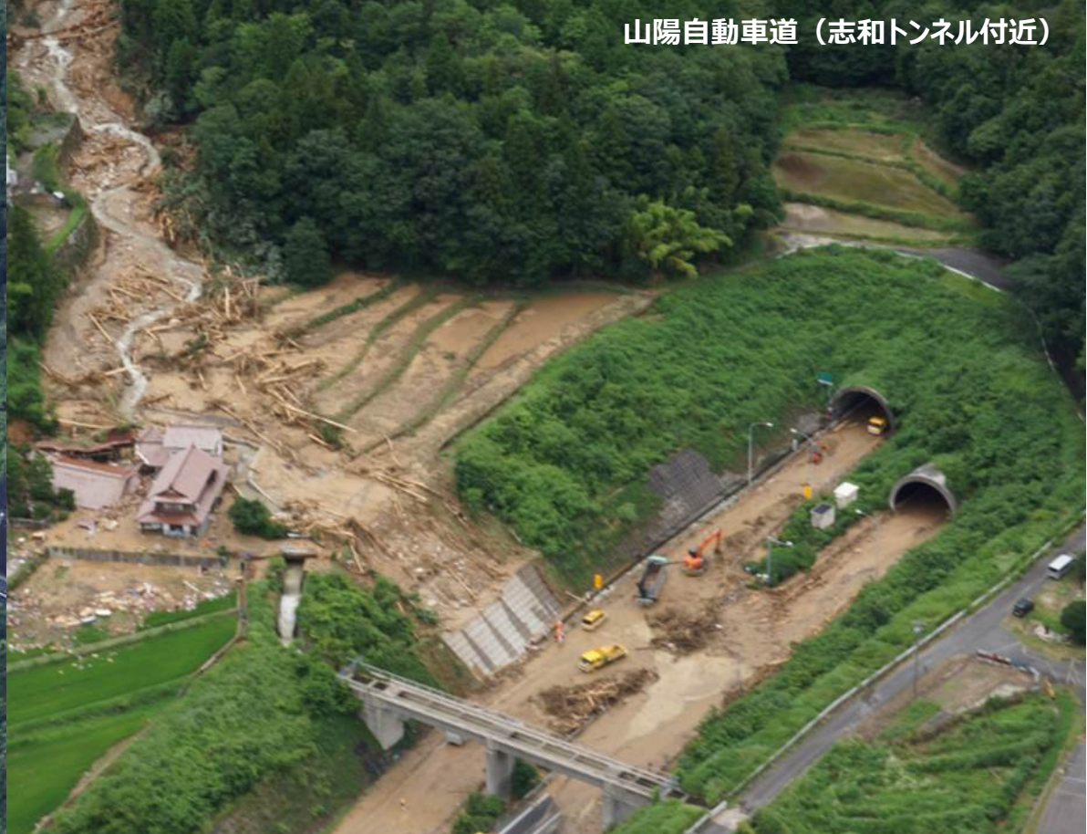
広島呉道路（安芸郡坂町水尻）
