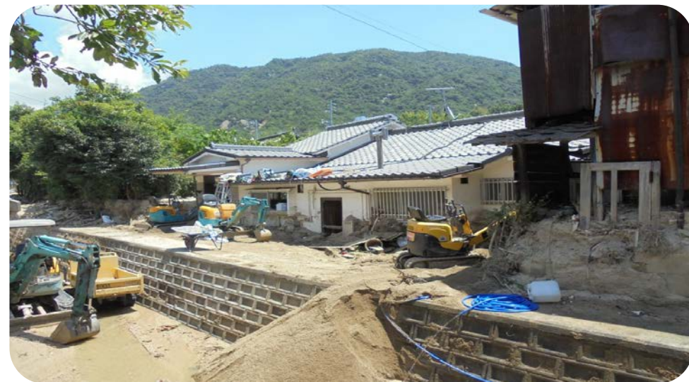
家屋に流入した土砂の撤去 (自衛隊・市町)
