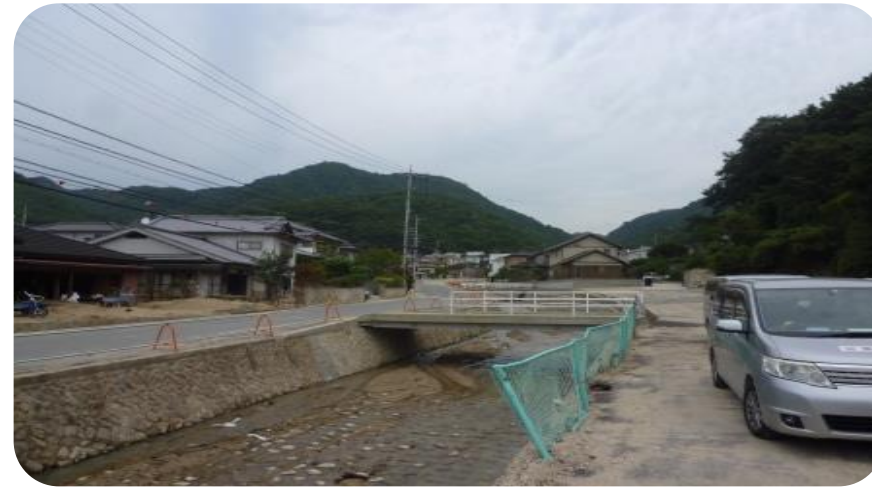
河川・道路の土砂を撤去
