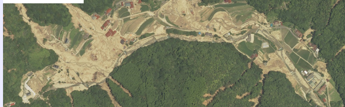
市原地区被災後
