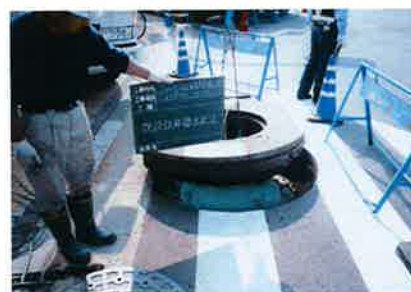
マンホール上部の撤去状況
