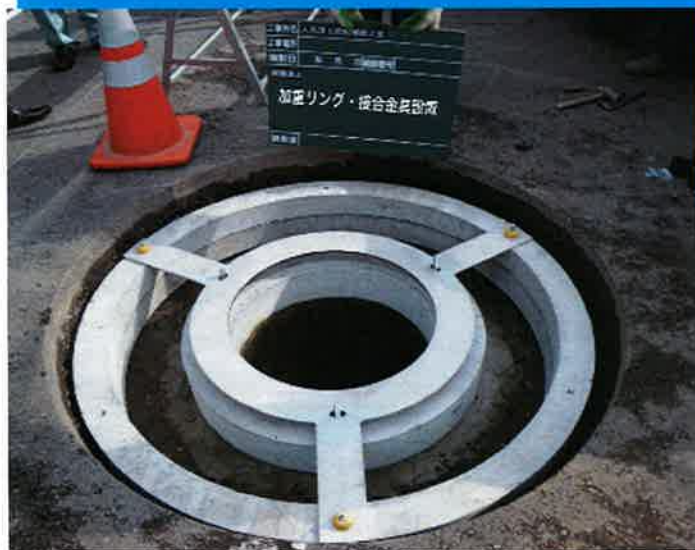
加重リング及び接合部材設置時
