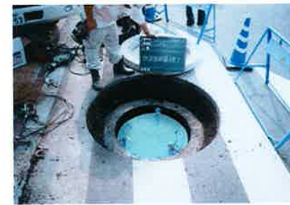
マンホール上部の撤去完了
