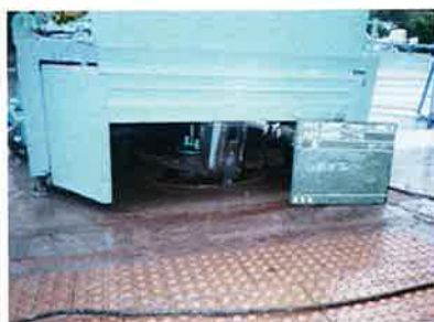
マンホール上部の切断作業
