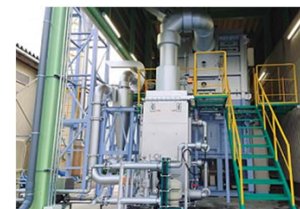
共同開発に成功したもみ殻処理炉
