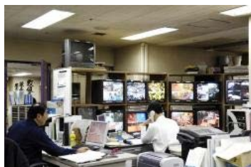
館内に設置されたコミュニケーションカメラ及び管理室
