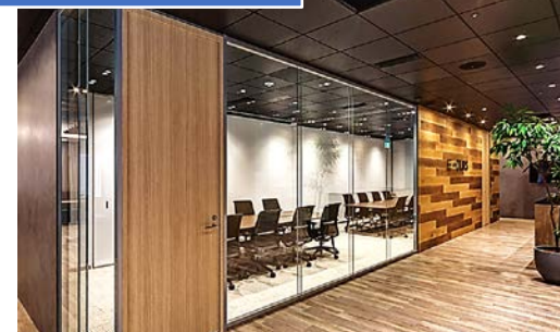
遮音性を高めた会議室のガラスパーティション
