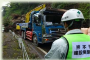
道路啓開(倒木・土砂の撤去)
