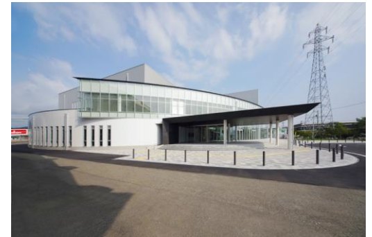
【実績】 越前市総合体育館の外観
