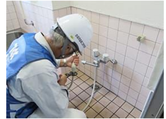
【実績】 配管設備点検の様子
