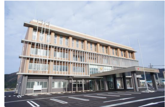
【実績】 小浜警察署の外観
