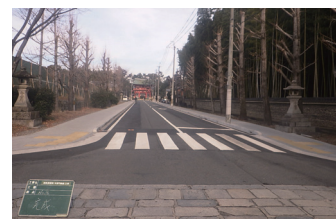
舗装道補修工事
