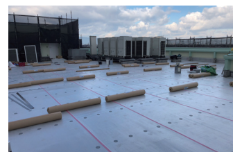
屋上防水改修
