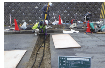
共同受注工事現場作業
