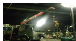
配水管布設工事
