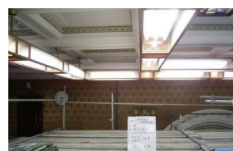
照明 LED 工事
