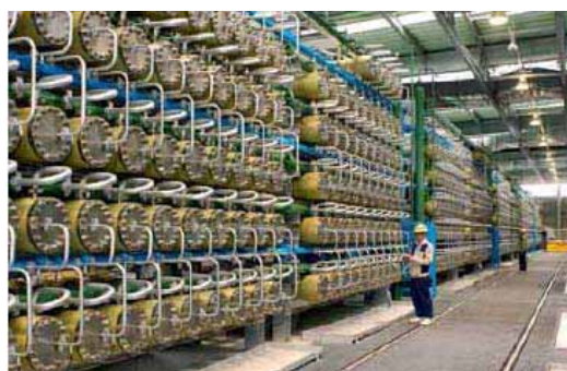
【中空糸型逆浸透膜を用いた海水淡水化施設】
