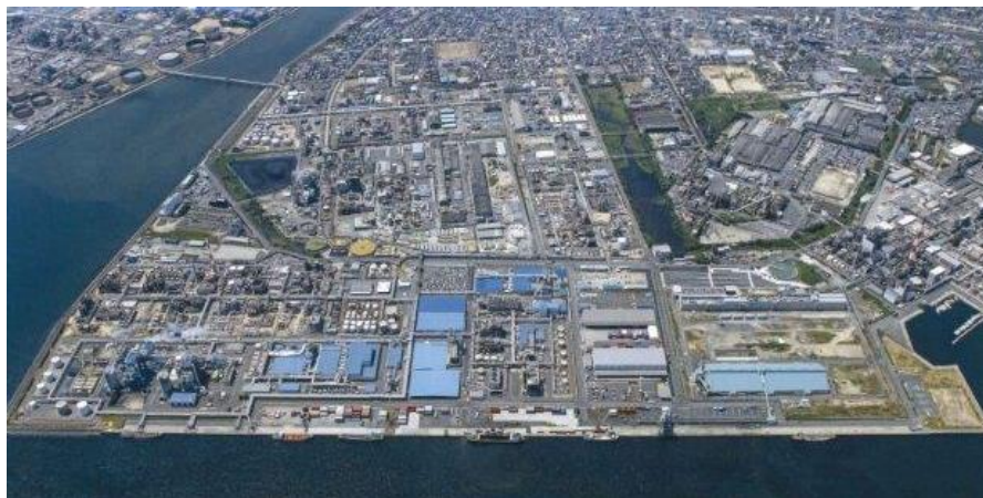
大竹港(写真下部)の岸壁側から空撮した大竹市。 大竹港の背後に大手の工場が立地している。 左は、県境を流れる小瀬川。
