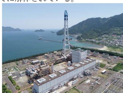
【解体前の発電所跡地(2019. 6)】
