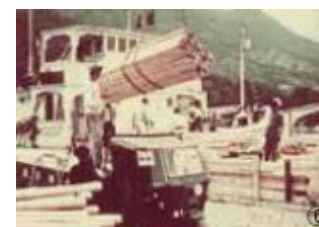
【ヒノキ材の搬出作業の様子】
