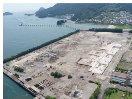
【解体後の発電所跡地(2021. 9)】
