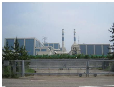
志賀原子力発電所
