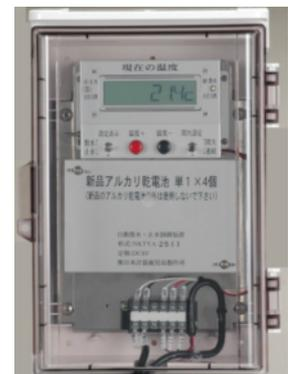
全自動散水・止水制御装置
