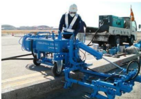
新型削孔機による削孔作業
