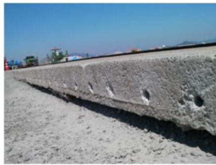
既設版削孔作業後の状況
