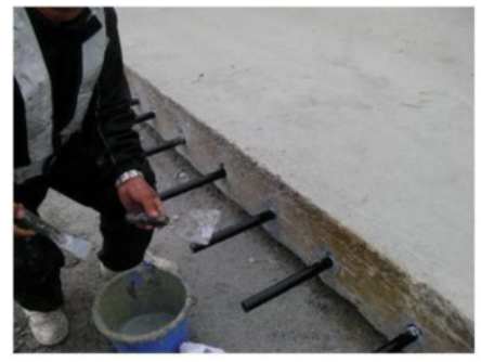
専用剤による棒鋼固定作業
