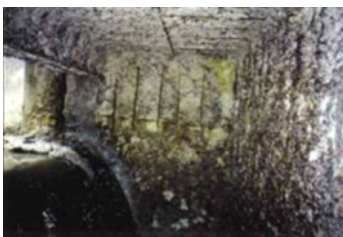
硫酸によるコンクリート劣化
