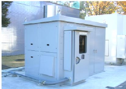
アンモニアガス処理装置
