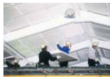
断熱工事の様子(内)
