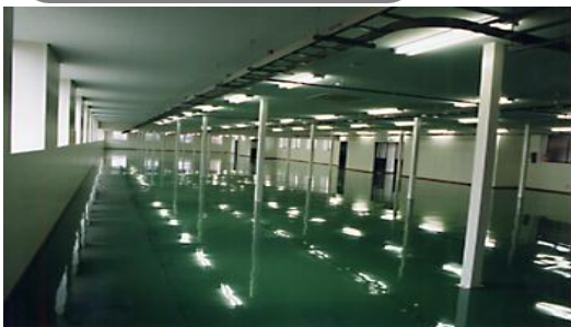
塗床施工完成例
