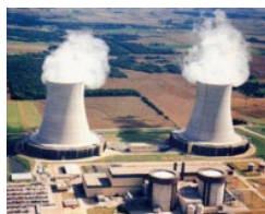
原子力発電所
