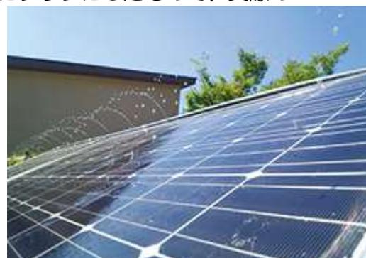
写真1 散水式冷却方式
