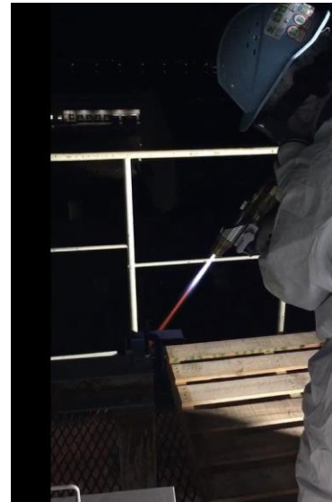
写真 3. 現地施工の様子 (同時試験片へ溶射している様子)
