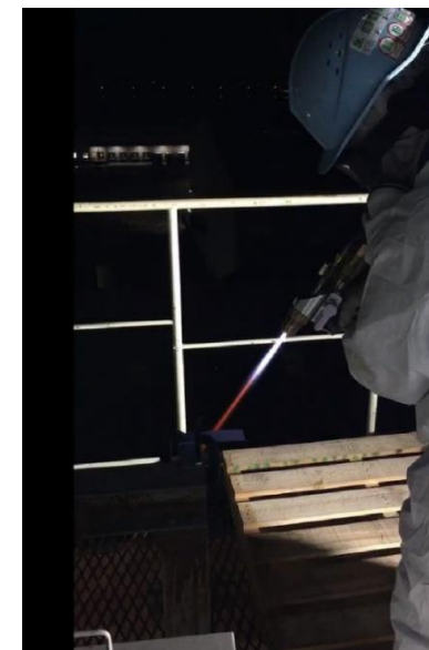
新溶射システム・材料による 現地施工実験
