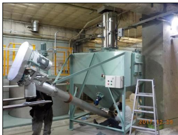
完全エアー式粉粒体真空搬送装置・ホッパー
