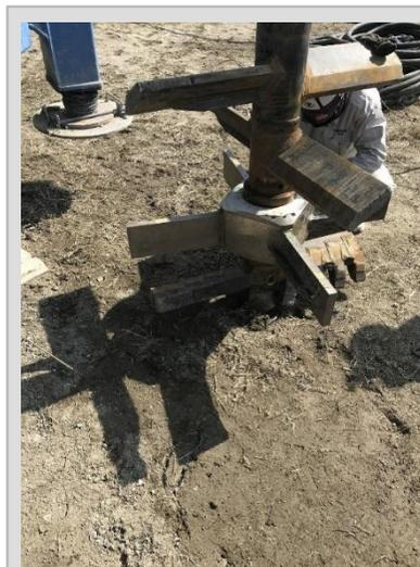
比抵抗計測ユニットを内蔵した地盤改良翼
