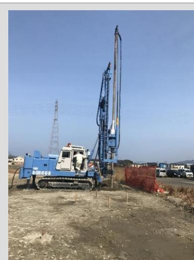
地盤改良試験にて比抵抗を計測
