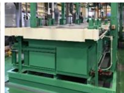
亜鉛アルミフレーク処理設備
