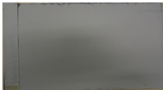
図 29 凹みや繊維の筋が残っているプライマー塗装表面
