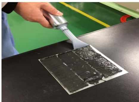
図 2-2-1 ペースト状隙間埋め材の施工検討
