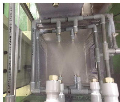
図65. シャワー噴霧中の様子
