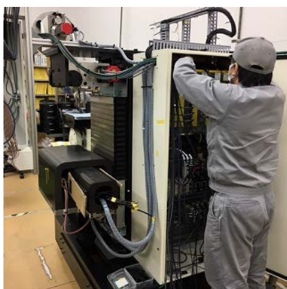
図 21 電装系の組付け作業
