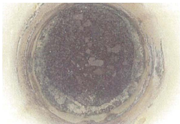
図5.炉床のパンチングメタル目詰まり
